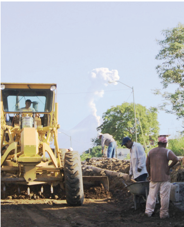
Pavimentación de la Avenida Xoloapan en la colonia Solidaridad.
